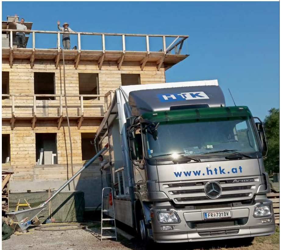
100 Prozent mineralisch: GEOLYTH bluesmart wird als brandsicherer Dämmstoff in die Hohlräume einer Holzriegelwand verfüllt.
