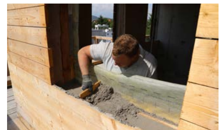
Bei einem Einfamilienhaus in Krems wurden rund 50 Kubikmeter des Füllstoffs GEOLYTH bluesmart verbaut.
