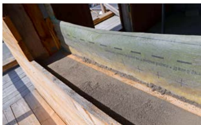
Bei einem Einfamilienhaus in Krems wurden rund 50 Kubikmeter des Füllstoffs GEOLYTH bluesmart verbaut.
